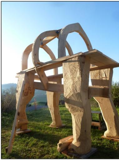
Tragkonstruktion mit Spanten wie im Schiffsbau
